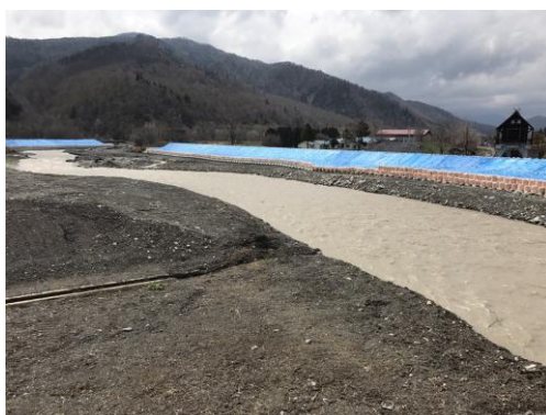
国道274号線：日高地区千栄
